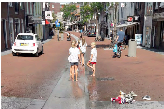
Bovengrondse waterafvoer. Referentie Woerden.
