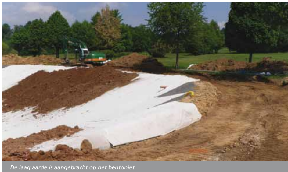
Bij het uitrollen van de bentonietmatten handelt de aannemer een overlap van 30 cm.
