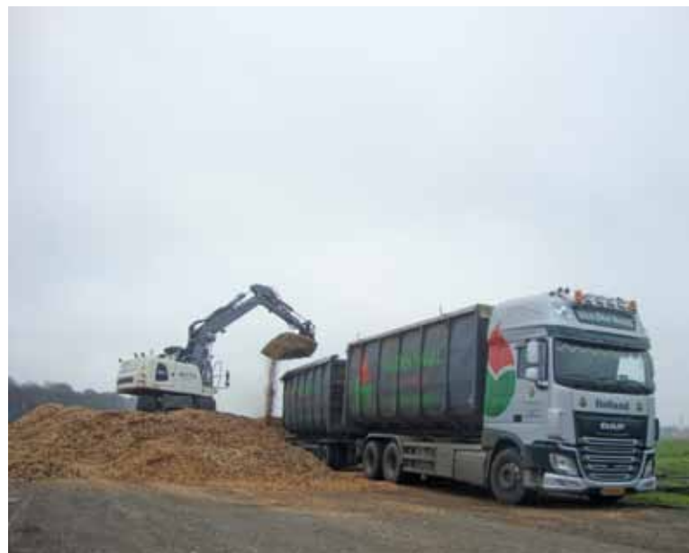
Bomen en takken werden op depot verwerkt.
