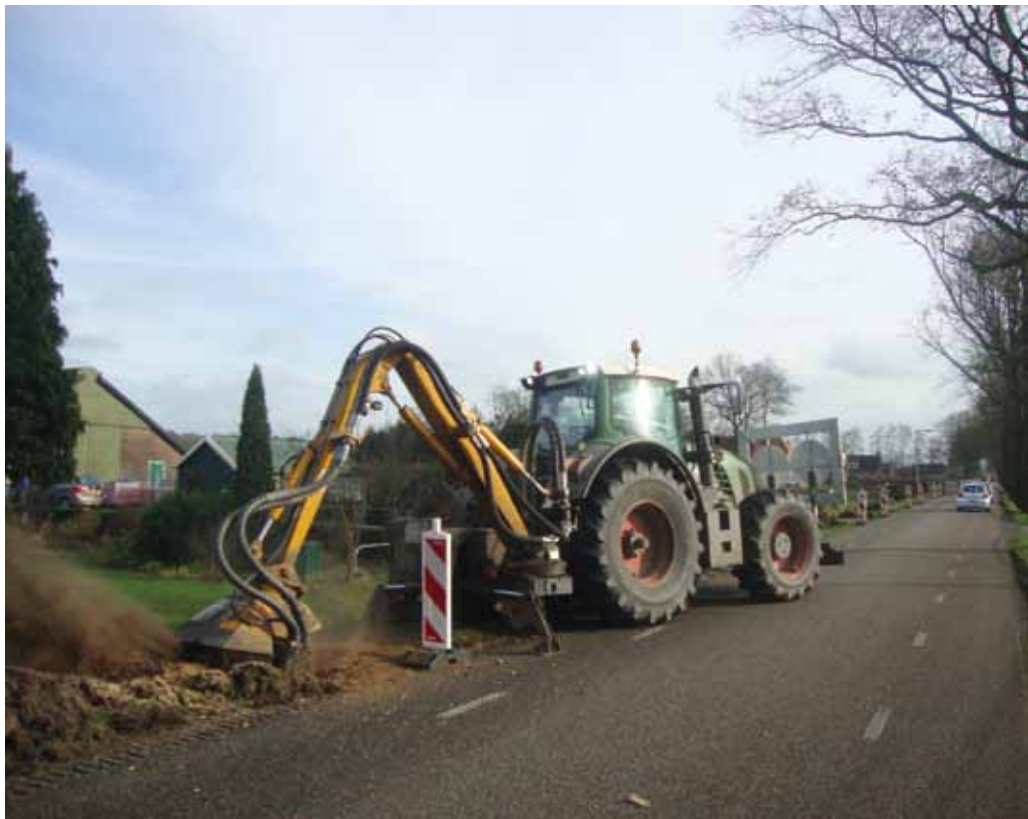
Enmaal gezaagd werden de achtergebleven stompen helemaal weggefreed.
