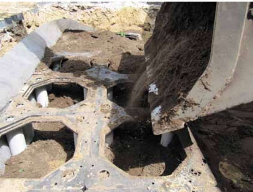
Met graafmachine vullen van het systeem.
