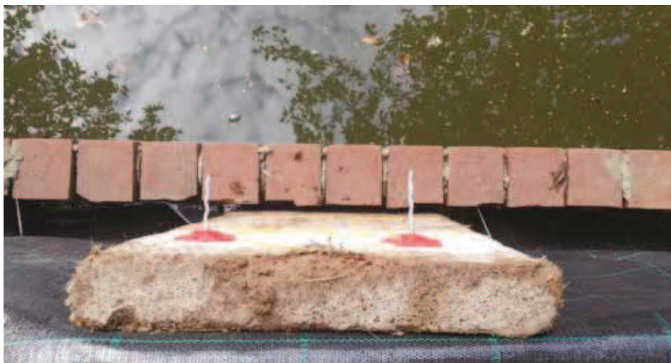
Detail aanzicht spouw met substraatplaten.
