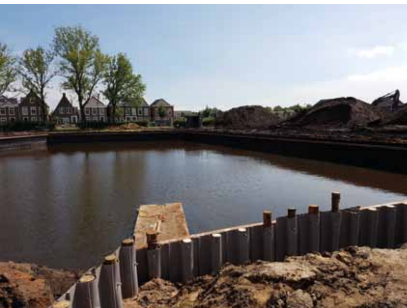
De oeverbescherming van Profextru is een combinatie van hout en pvc.
