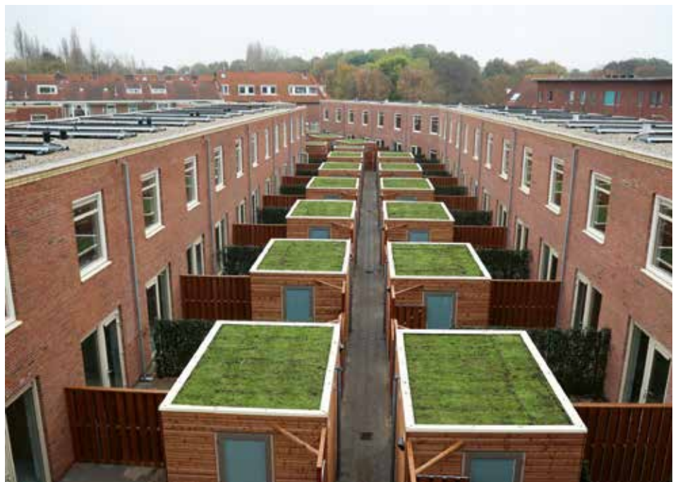
De bergingen van de woningen zijn voorzien van sedumdaken. Foto T&G Groep
