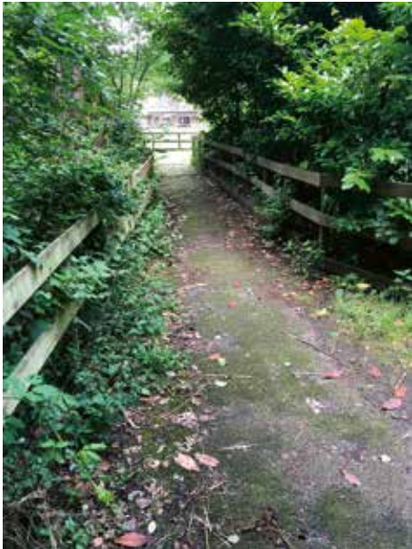
Het nieuwe pad wordt aangebracht.
