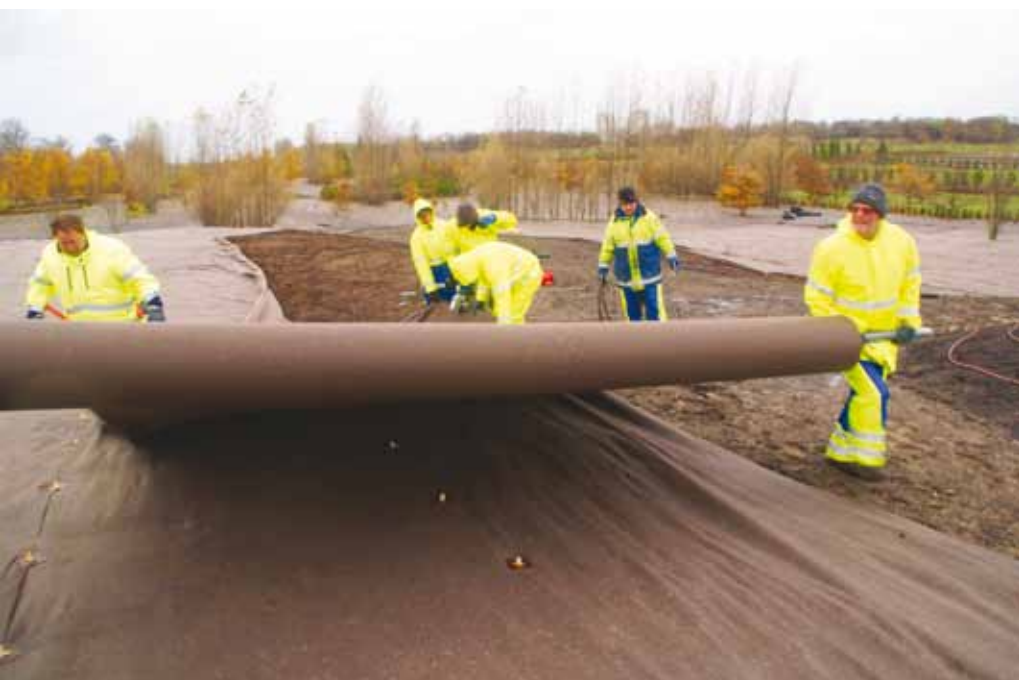
Aanleg van onkruiddoek voor een project in Malmö.
