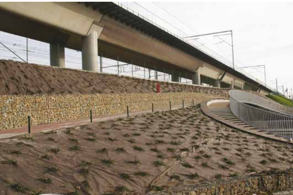
Project op een spoorwegtalud in Gent.
