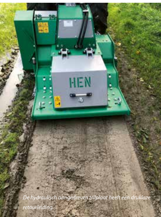
Een met schelpen halfverhard pad wordt gefreesd.
