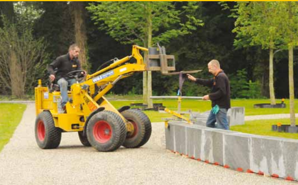
Als ik het campustuin bezoek is de officiële opening net achter de rug. Hiervoor waren de net niet helemaal maatvaste hardsteen zitelementen die in regio geleverd waren alvast maar geplaatst. Op de foto worden de elementen verwijderd om maatvast te maken. Bomen als hier een groepje van onderaf geveerde beuken zijn belangrijk in het MTD ontwerp van het Thales campuspark. Het park moet meteen vanaf dag een volwassen aanblik geven.
