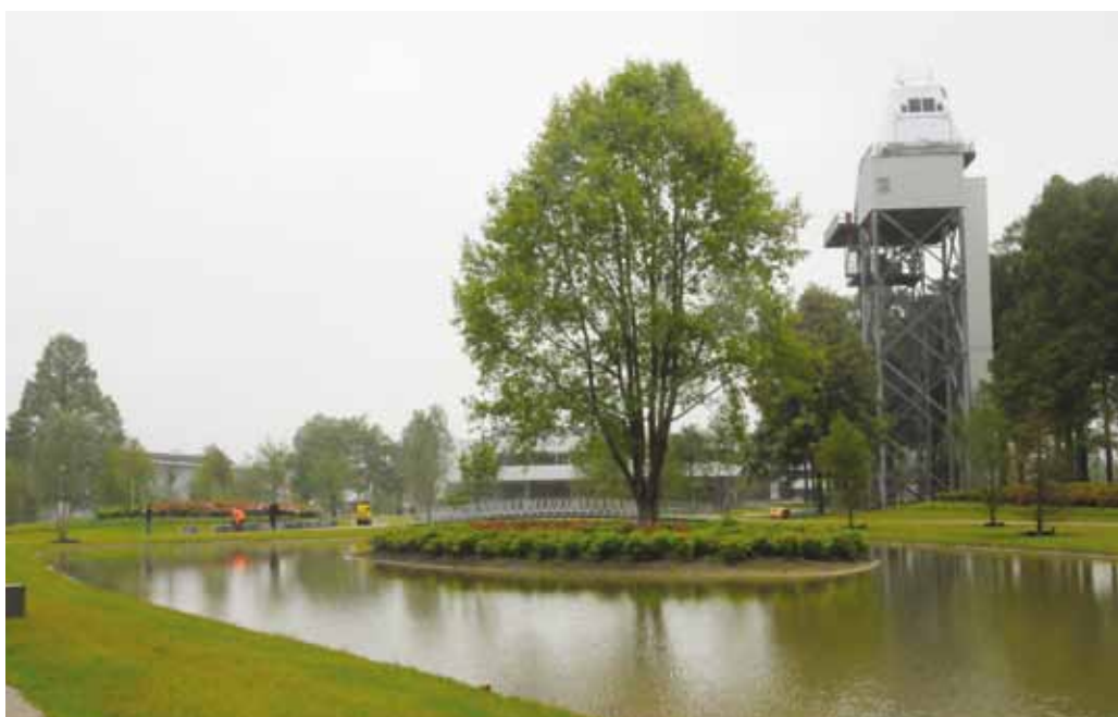
Centrale eiland in de Thales campustuin met op de achtergrond de testtoren waar de radarapparatuur van Thales getest wordt.
