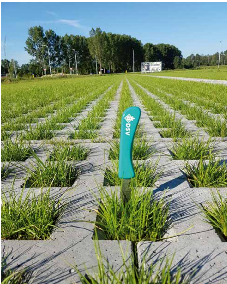
In Best ligt een parkeerterrein van 5500 m2 met substraten van BVB, gras-betonelementen van Swaans Beton en een grasmengsel van DSV zaden Nederland.
