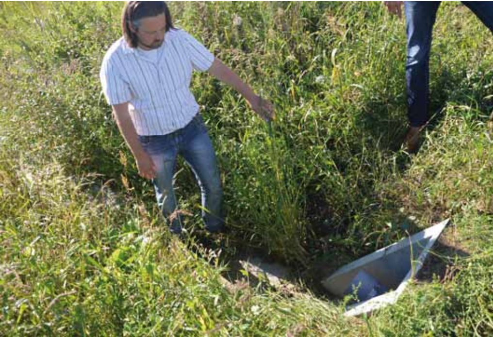
Uitmonding van een drainagesysteem.
