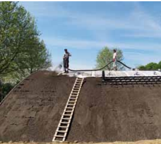
Stap 3: substraat aanbrengen
