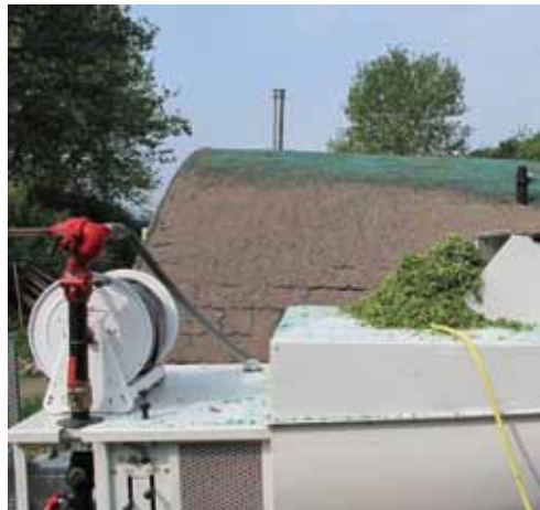
Stap 4: De hydroseeder is gevuld met mulch en wordt hier gemengd met stekken.
