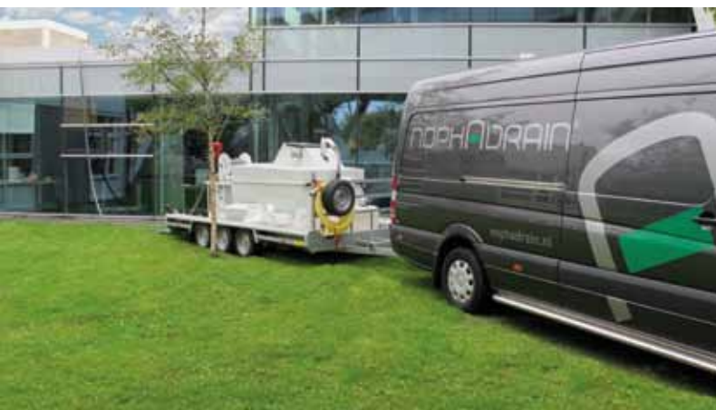
De hydroseeder blijft tijdens het werk op de grond staan.
