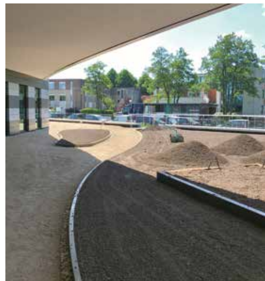
Halfverharding (split) (links), en substraat (rechts), klaar om vegetatie in te planten. Foto: Nophadrain.
