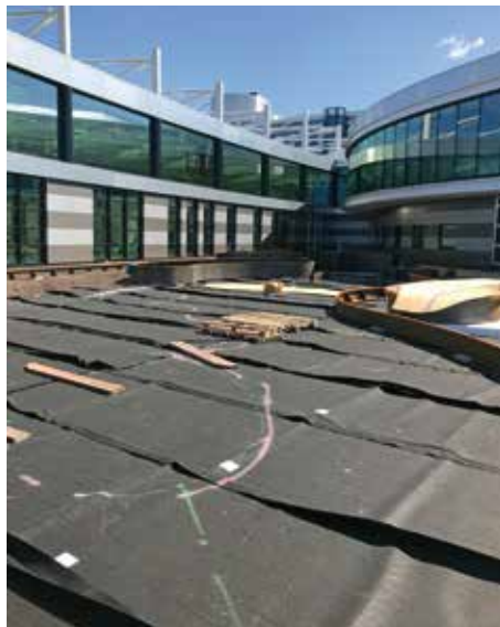
ND 5+1 drainagesysteem uitgerold, overlap met vlies gemaakt. De randen van de plantenbakken zijn op het systeem geplaatst waardoor een teveel aan water altijd afgevoerd kan worden. Midden: ND 5+1 drainagesysteem uitgerold met overloop. Rechts: ND 620hd drainagesysteem met daaronder de ND TSF-100 glij- en beschermfolie. Foto's: Nophadrain.
