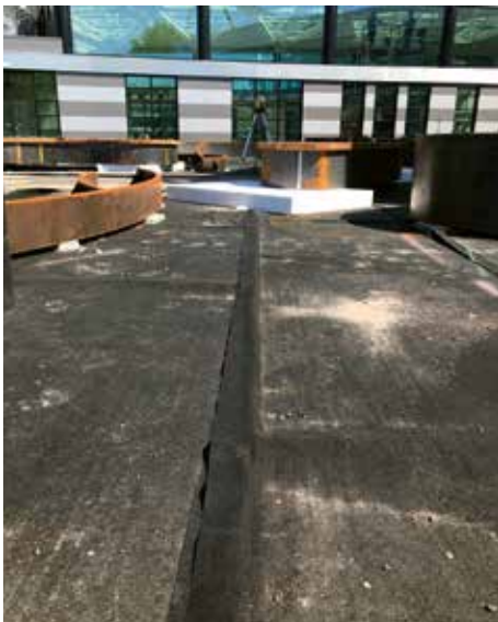
ND 5+1 drainagesysteem uitgerold, overlap met vlies gemaakt. De randen van de plantenbakken zijn op het systeem geplaatst waardoor een teveel aan water altijd afgevoerd kan worden. Midden: ND 5+1 drainagesysteem uitgerold met overloop. Rechts: ND 620hd drainagesysteem met daaronder de ND TSF-100 glij- en beschermfolie. Foto's: Nophadrain.
